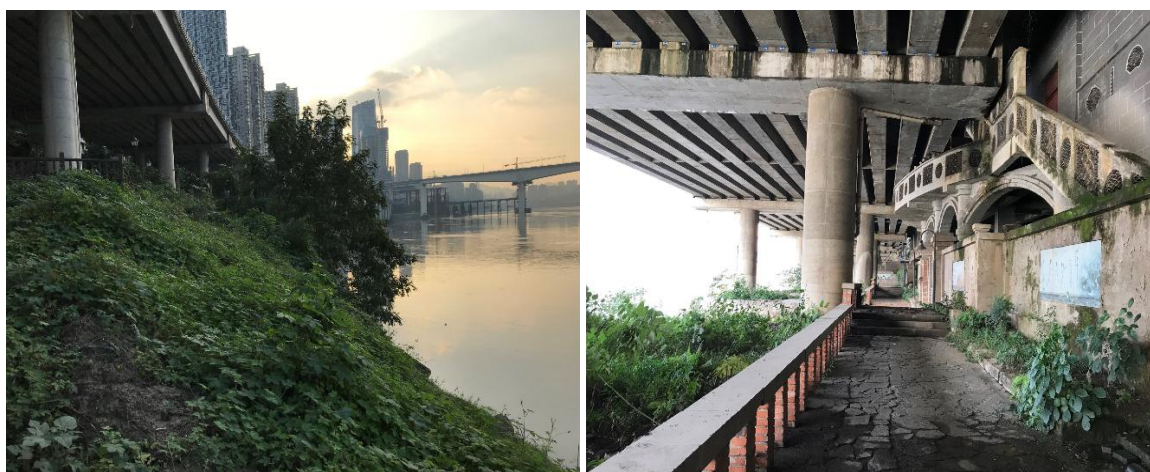
图 3.2-4 李子坝抗战公园至李子坝轻轨站段现状植物照片
